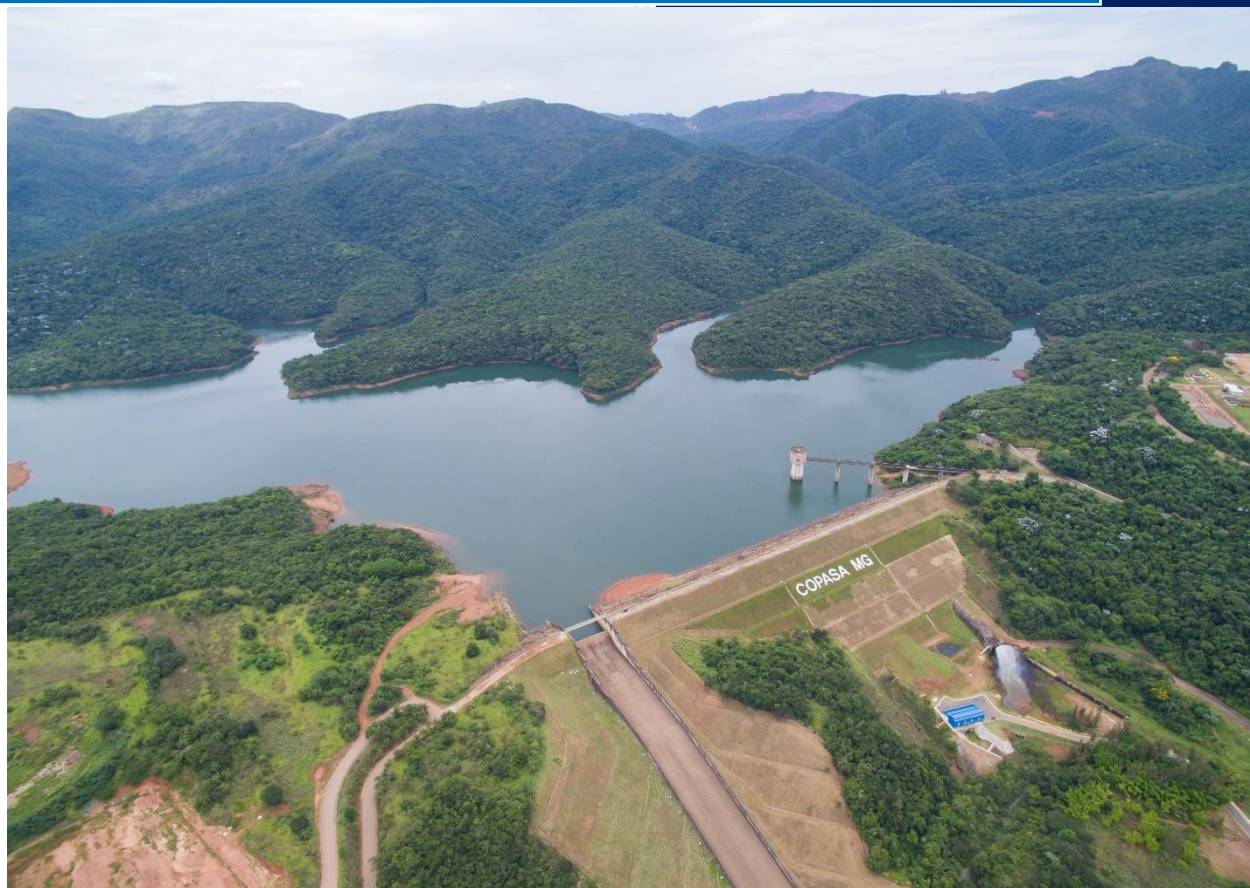
Barragem Rio Manso. Fonte: Arquivo Copasa.
