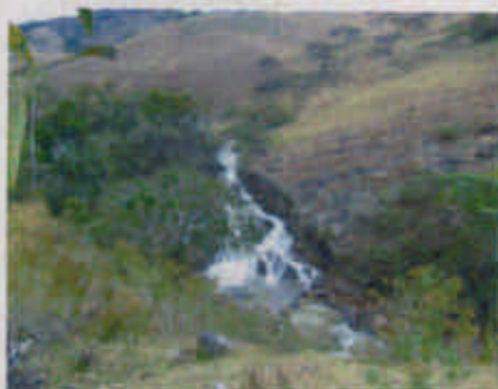
Figura 05 – Vista de jusante de parte do TVR.
