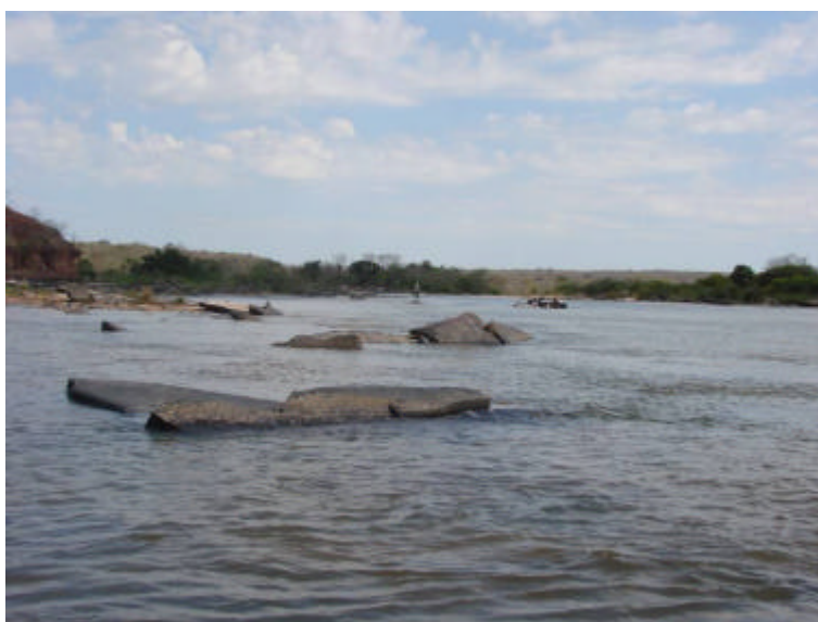
Foto 01 - rio do Sono – Trecho da Vazão reduzida
