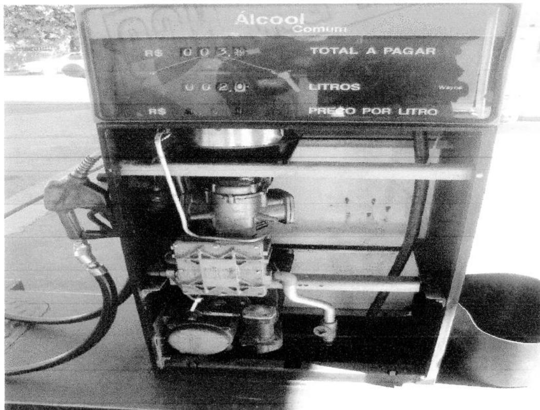
Foto 06: Bomba de combustível com SUMP.
