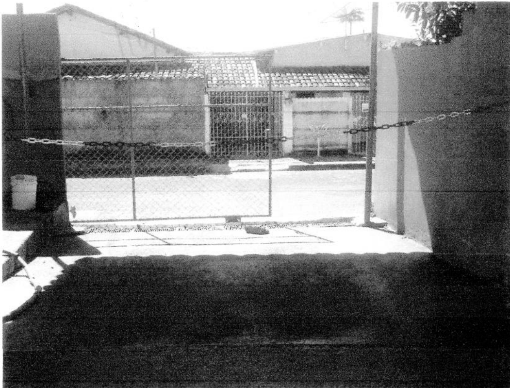
Foto 08: Lavador de onde a água do lavador vai direto para rede de esgoto sem passar pela caixa separadora de água/óleo.
