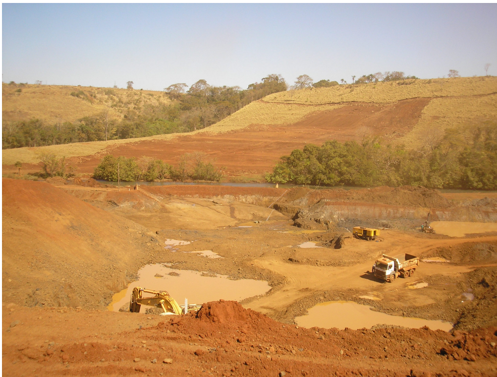
Foto 1: Vista geral do local de implantação da barragem e área parcial que será inundada.
