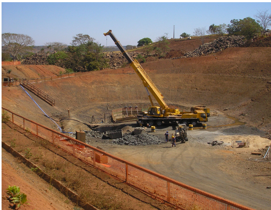
Foto 3: Tomada d'água em construção
