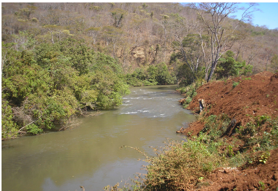
Foto 4: Vista parcial do trecho de vazão reduzida
