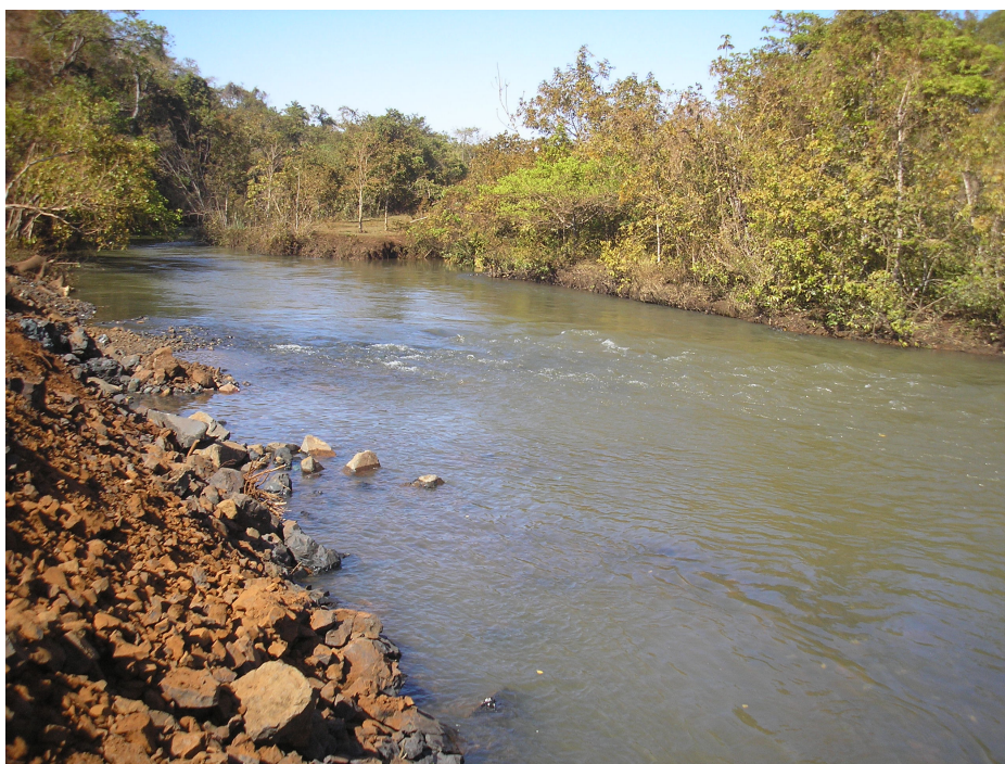
Foto 2: Vista à montante do eixo da barragem
