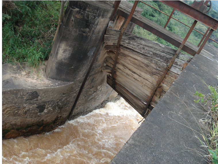
Figura 3: comporta lateral ao barramento
