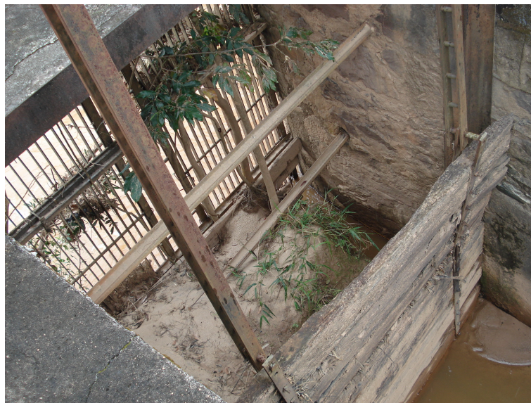
Figura 4: comporta da entrada do canal de adução
