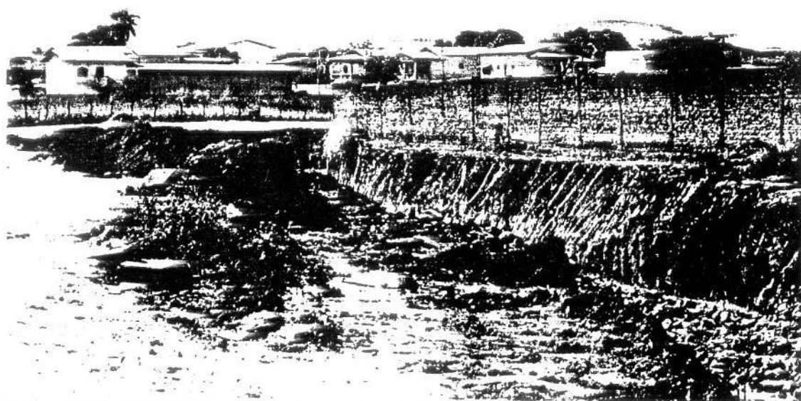
Trecho do canal mostrando o enrocamento de fundo e a ocupação da margem direita
