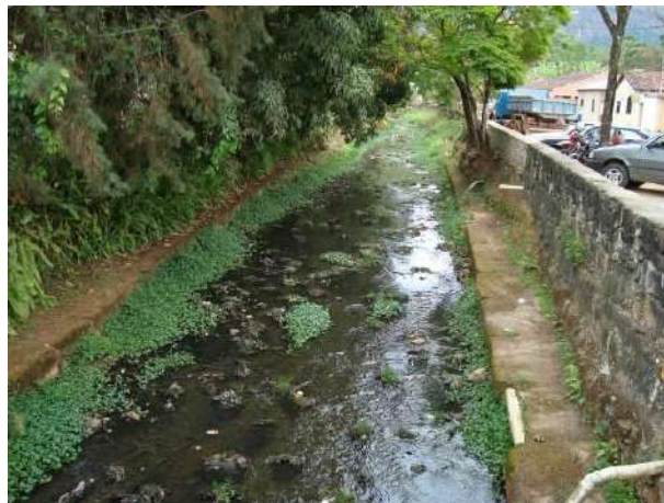
Figura 57 - Ponto de lançamento de efluentes domésticos e industriais da sede municipal de Tiradentes.
