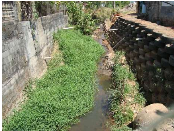
Figura 68 - Ponto de lançamento de efluentes domésticos e industriais do distrito de Pedra do Sino (Carandaí) e imediações.
