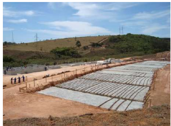
Figura 31 - Obras da estação de tratamento de efluentes da sede municipal de Barbacena.
