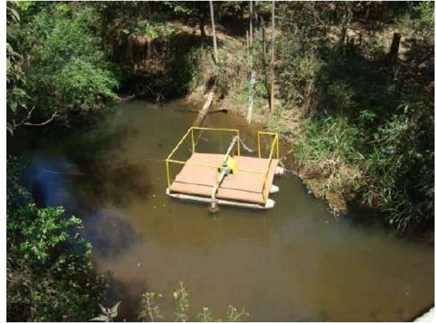
Figura 27 - Ponto de captação para abastecimento doméstico do distrito de São Sebastião de Campolide (Antônio Carlos).
