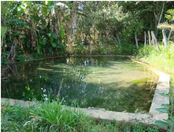
Figura 90 - Ponto de captação para abastecimento doméstico do povoado rural Pitangueiras (Prados).
