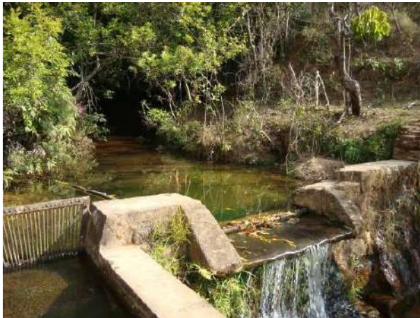
Figura 103 - Ponto de captação para o abastecimento doméstico e industrial da sede municipal de São João Del Rei, córrego Rio Acima.
