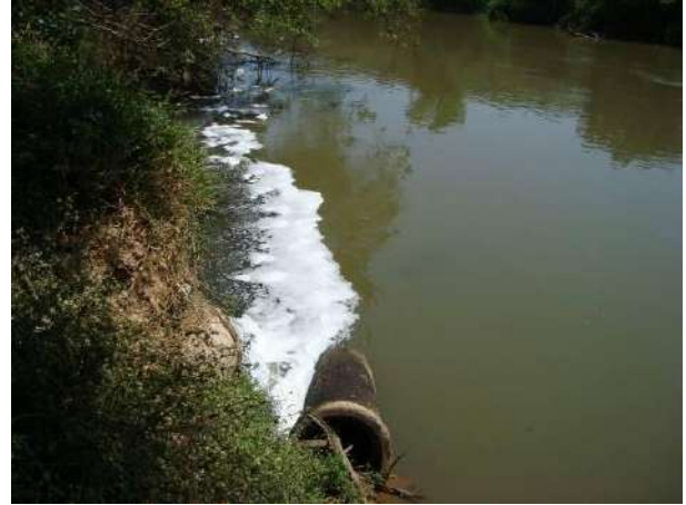
Figura 98 - Ponto de lançamento de efluentes tratados da sede municipal de São João Del Rei (Bairro Colônia do Marçal).
