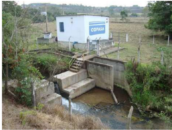
Figura 32 - Captação para o abastecimento doméstico e industrial da sede municipal de Barroso.
