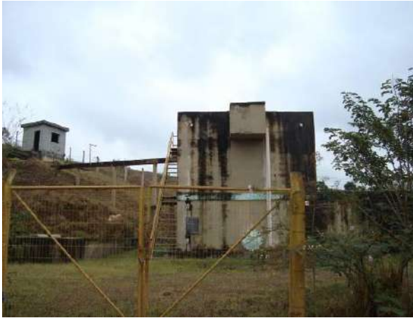
Figura 8 - Estação de tratamento de esgoto da sede municipal de Barroso trata aproximadamente 10 % dos efluentes da sede municipal.
