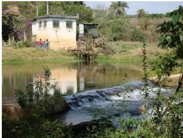
Figura 102 - Captação para abastecimento doméstico e industrial da sede municipal de São João Del Rei.
