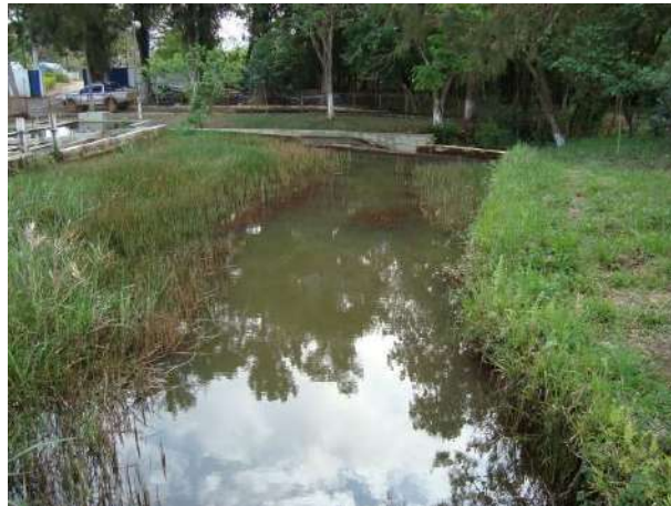
Figura 33 - Captação para o abastecimento doméstico e industrial da sede municipal de Barroso.
