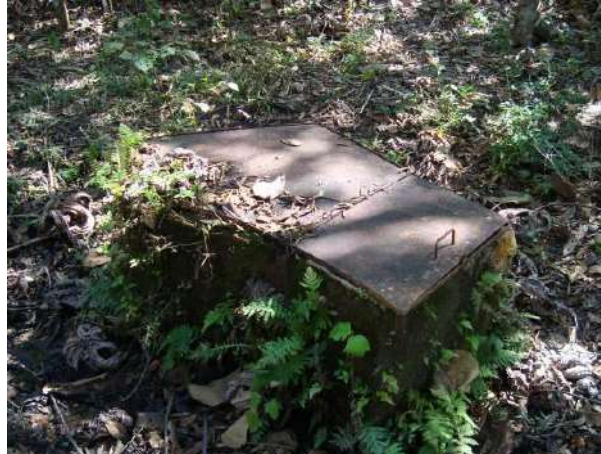
Figura 24 - Ponto de captação para abastecimento doméstico do distrito de Pinheiro Grosso (Barbacena).
