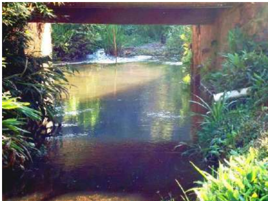
Figura 79 - Ponto de lançamento de efluentes domésticos do distrito de Paraíso Garcia (Santa Rita do Ibitipoca).
