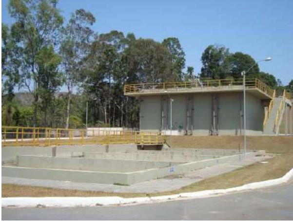
Figura 97 - Estação de Tratamento de efluentes da sede municipal de São João Del Rei (Bairro Colônia do Marçal).
