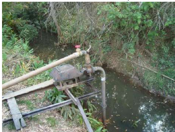
Figura 105 - Ponto de captação para o abastecimento doméstico e industrial da sede municipal de São João Del Rei, córrego Altamiro Braga.
