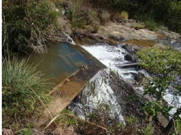
Figura 25 - Ponto de captação para abastecimento doméstico e industrial da sede municipal de Antônio Carlos.
