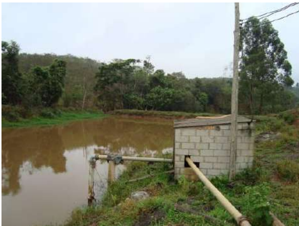
Figura 59 - Ponto de captação para irrigação tipo aspersão (Tomate, repolho, vagem e ervilha.).
