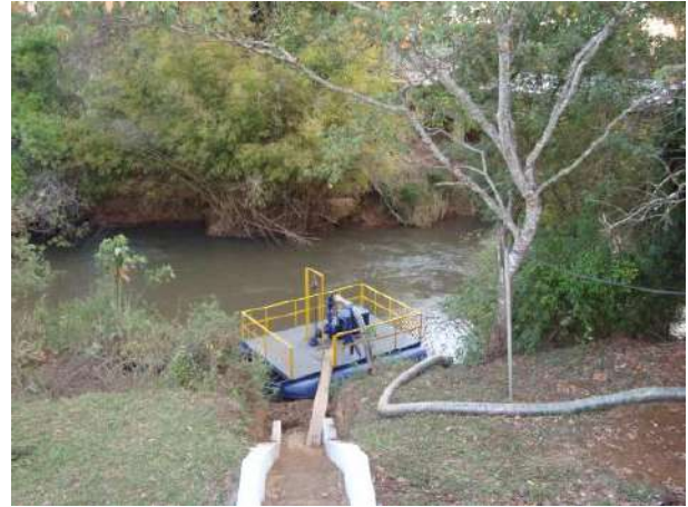
Figura 85 - Em destaque a balsa de captação para o abastecimento doméstico e industrial da sede municipal de Tiradentes.
