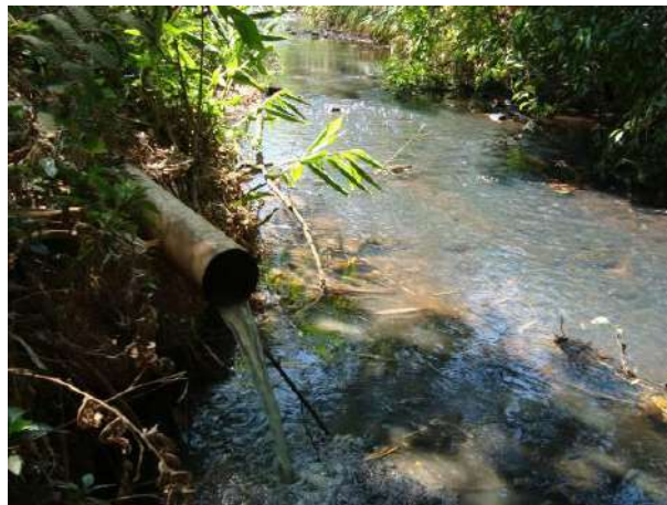
Figura 54 - Ponto de lançamento de efluentes domésticos do povoado rural Bichinho (Prados). Fonte: Ecoplan-Lume-Skill, 2011.
