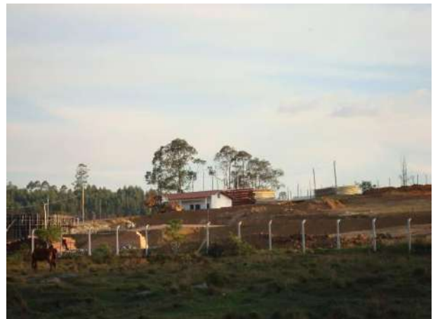
Figura 117 - Obras da estação de tratamento de esgoto da sede municipal de Resende Costa.
