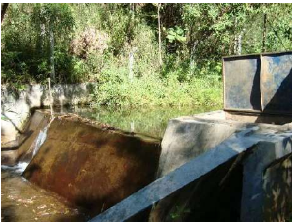
Figura 86 - Ponto de captação para abastecimento doméstico da sede municipal de Santa Rita do Ibitipoca.
