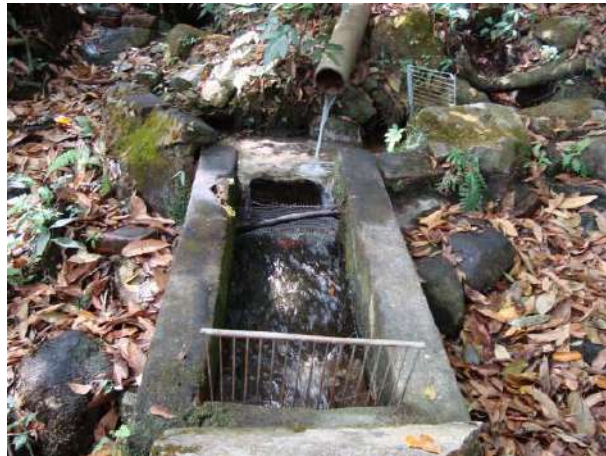
Figura 108 - Ponto de captação para o abastecimento doméstico e industrial da sede municipal de Santa Cruz de Minas.
