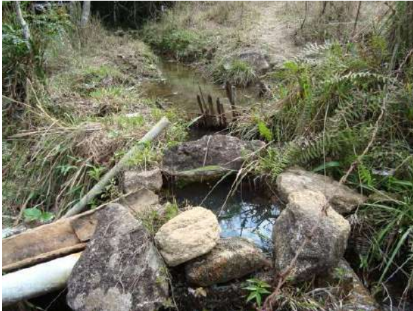
Figura 110 - Ponto de captação para o abastecimento doméstico da localidade rural Ribeirão Santo Antônio (Resende Costa), localizado no ribeirão de Cima.
