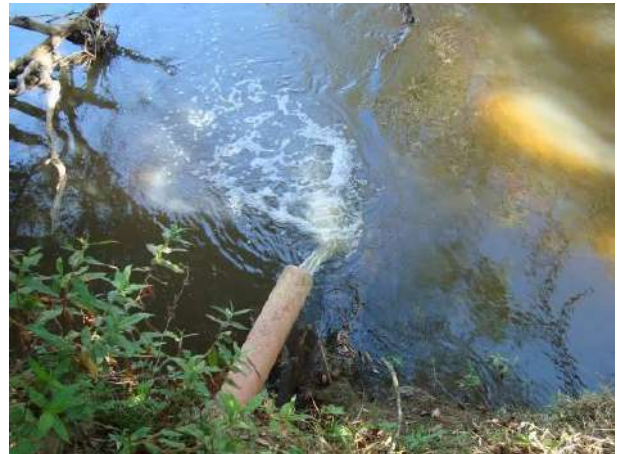
Figura 83 - Lançamento de esgoto tratado da sede municipal de Ibertioga.
