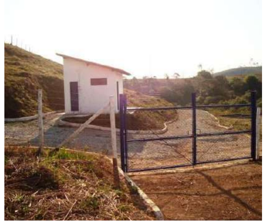
Figura 44 - Estação de tratamento de esgoto de Ressaquinha.
