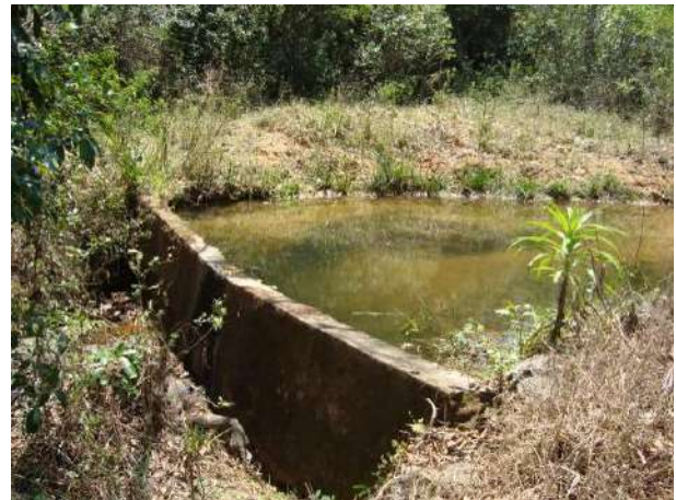
Figura 56 - Ponto de captação para o abastecimento doméstico e industrial da localidade rural de Bichinho (Prados).
