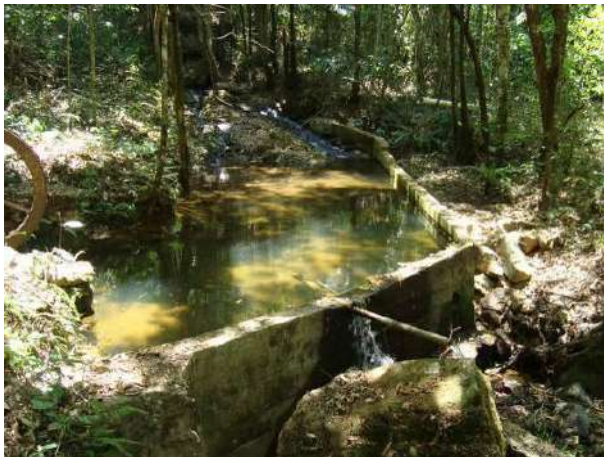
Figura 55 - Ponto de captação para o abastecimento doméstico e industrial da localidade rural de Bichinho (Prados).
