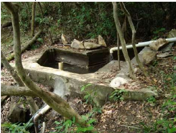
Figura 112 - Ponto de captação para o abastecimento doméstico da localidade rural Pintos (Resende Costa), localizado no ribeirão dos Marianos.
