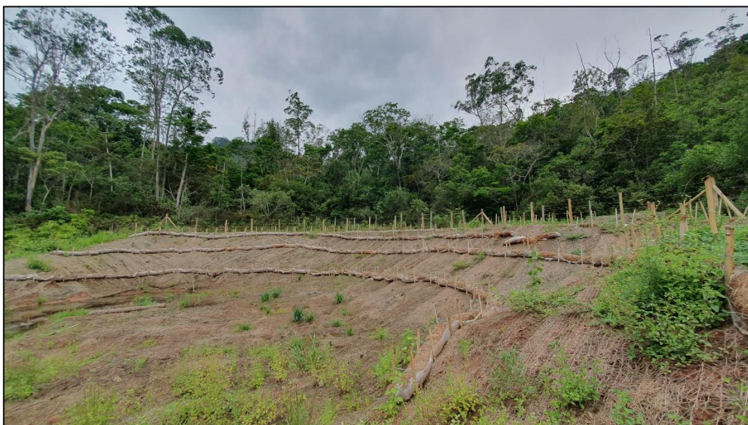
Foto 6: Inserção de biorretentores e biomantas no talude, que se apresenta exposto.
